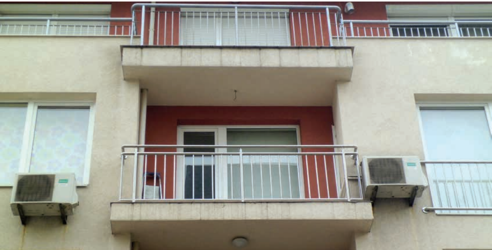
Иноксов парапет с квадратни колонки, квадратна ръкохватка и хоризонтален правоъгълен профил носещ вертикални тръби
